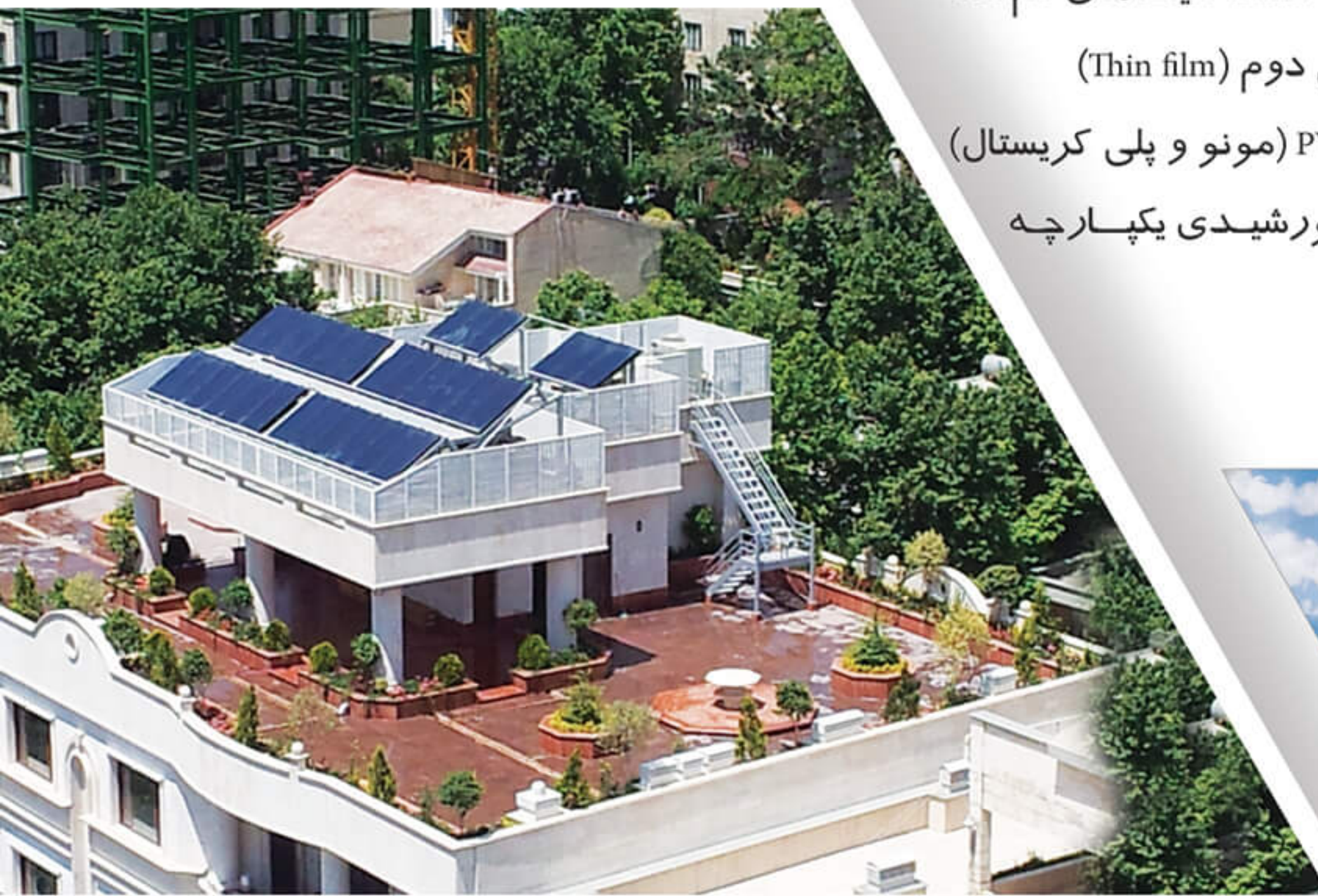
نمایی از پروژه اجرا شده
